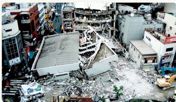
倒壊したコープこうべ本部ビル
